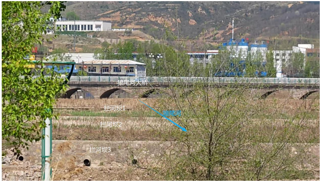
图 3-6 狼尾河拦河堤照片
