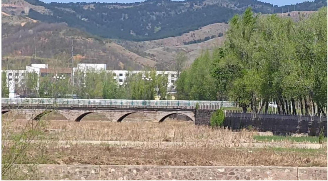
图 3-9 公路局桥段河道照片
