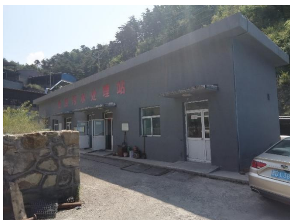
一号生活污水处理站
