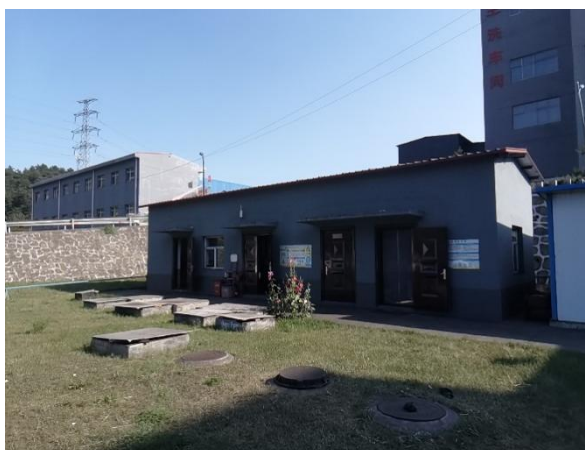
二号生活污水处理站
