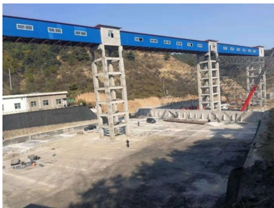
全封闭输煤栈桥
