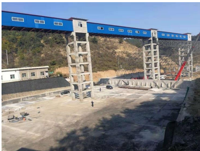
全封闭皮带走廊
